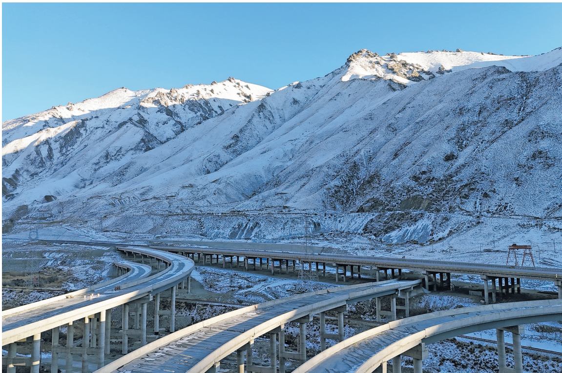
正在建设中的布然隧道以及新光枢纽互通,该互通建成后将实现那巴公路与乌尉高速互联互通,进一步完善天山北麓区域公路路网。(资料图片)
