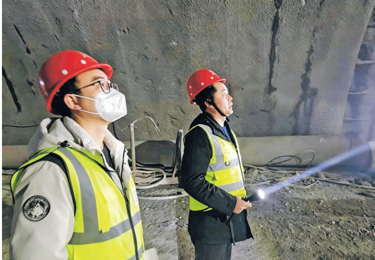
2026年1月,布然特长隧道贯通前夕,贵州公路集团那巴公路九标、十标项目负责人杨小珠(右一)在洞内指导隧道开挖施工作业。(资料图片)
