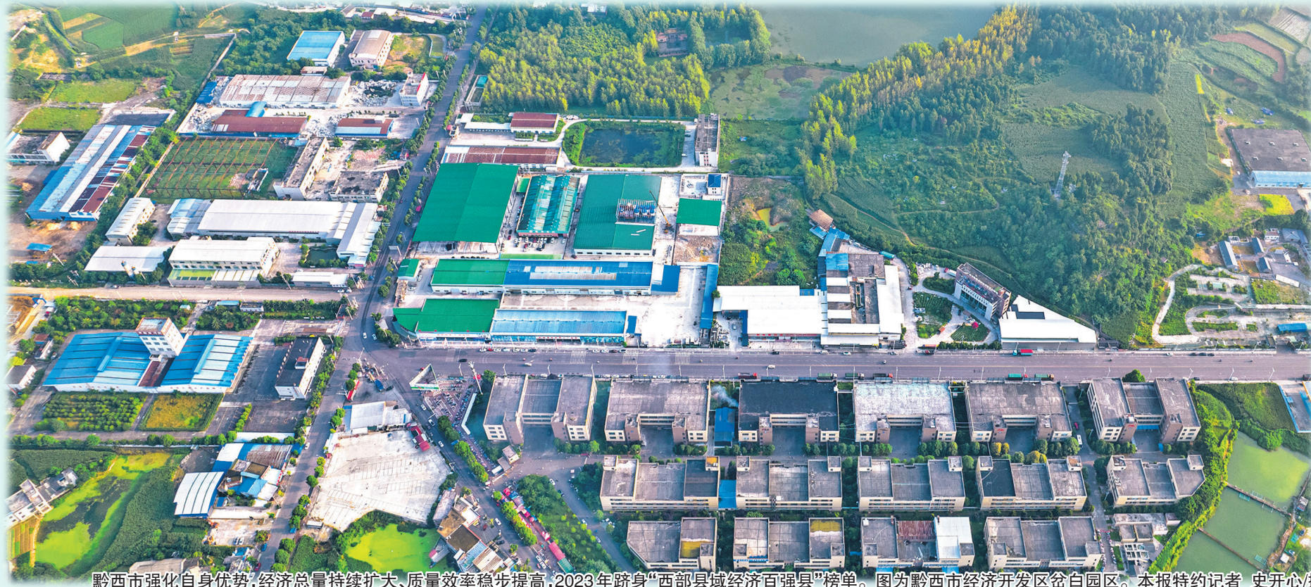
黔西市强化自身优势,经济总量持续扩大、质量效率稳步提高,2023年跻身“西部县域经济百强县”榜单。图为黔西市经济开发区岔白园区。本报特约记者 史开心/摄
