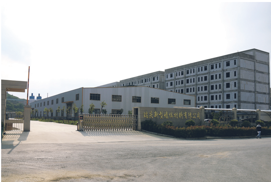
民盟中央引进项目——毕节市瑞庆新型墙体材料有限公司。
