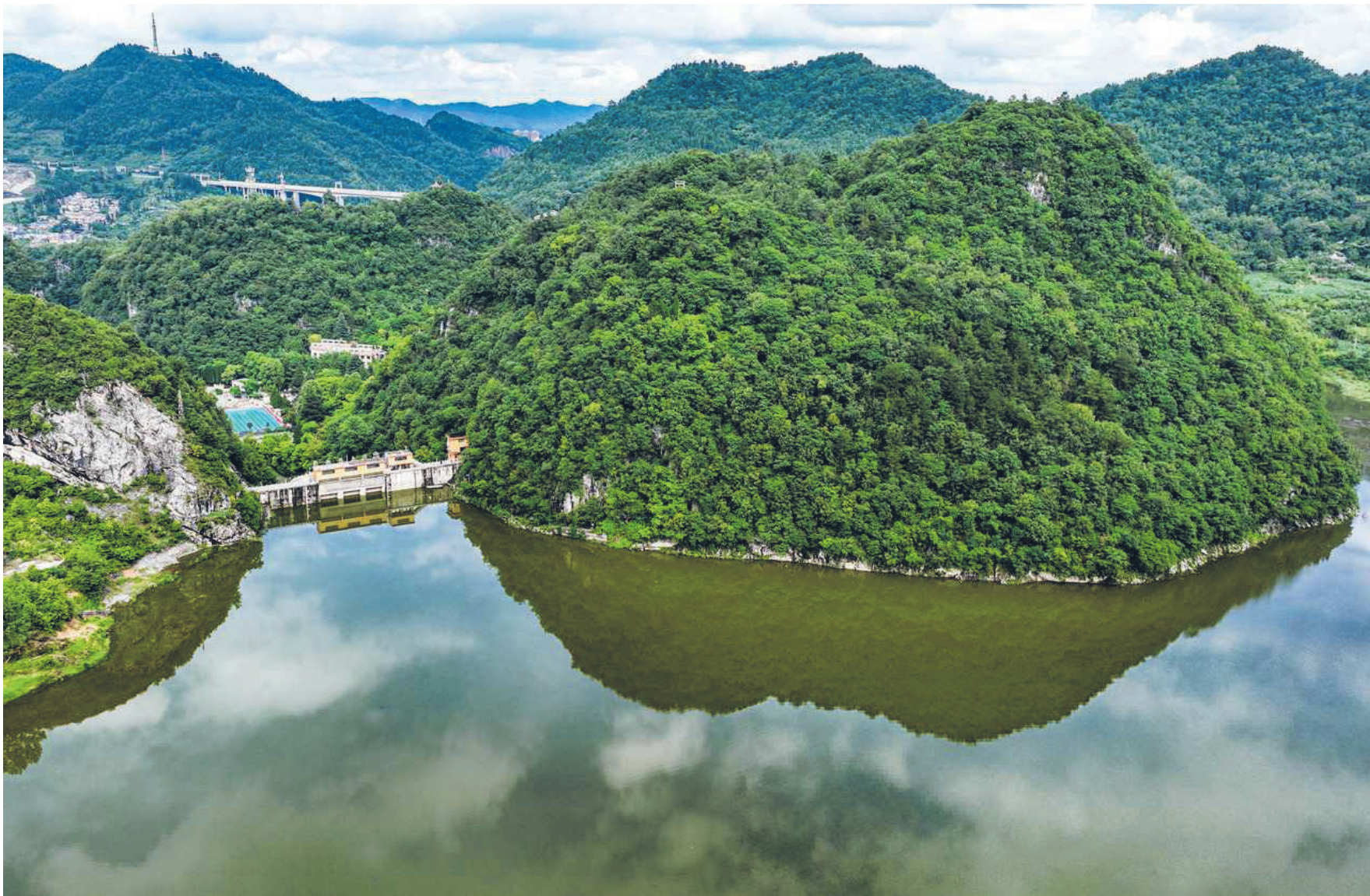
民盟中央参与协调立项的毕节倒天河水库大坝加高扩容综合治理工程。
